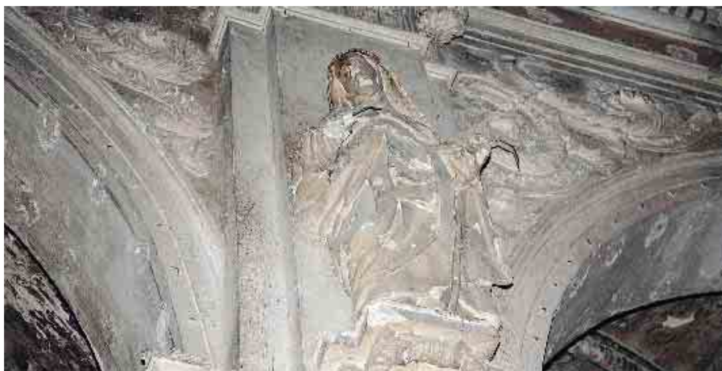
Un particolare delle figure ad altorilievo che decorano la sommità dei pilastri del Carmine, a loro volta molto ammalorate
